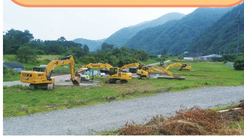
バイパスの工事現場
