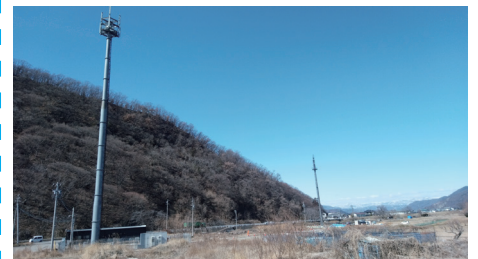
建設が進むバイパス工事 (並んでそびえる新旧携帯電話基地局)
