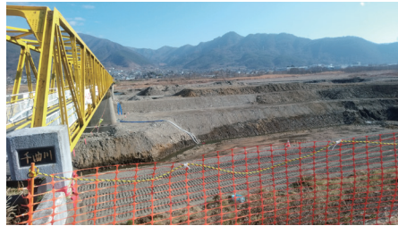
千曲川河川敷の復旧工事の様子
