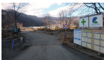
台風災害復旧 工事(3月)
